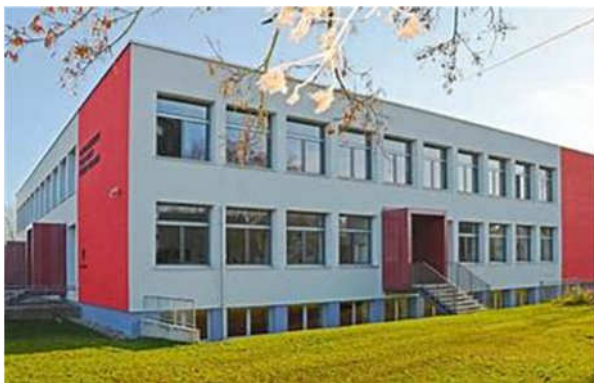
Foto: Westfassade des Gymnasium Gerolzhofen, ohne jede äußere Beschattung
